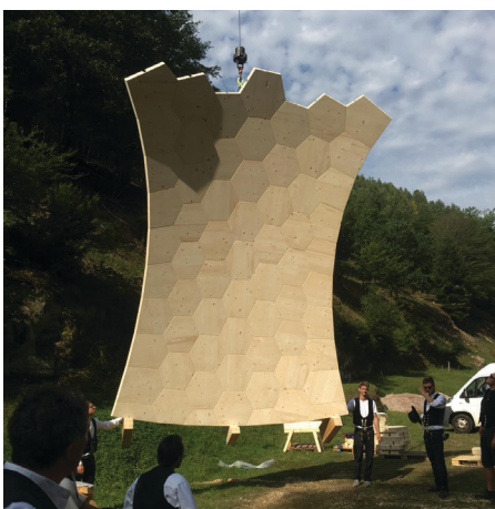
Die Anlieferung der Scheiben zeigt die Vorteile der Vorfertigung
