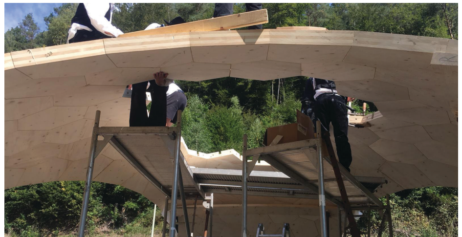
Die Zusammenarbeit zwischen Handwerk und Technologie zeigt sich beim Aufbau
