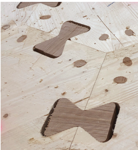
Halten den Pavillon zusammen: Holzverbinder aus Brettschichtverbundholz
